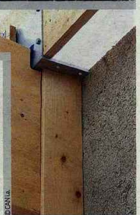
▲ Conçus comme un mur manteau, les panneaux sont emboîtés et fixés aux poteaux porteurs.
