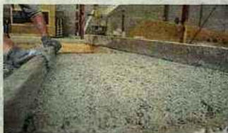
L'épaisseur du béton de chanvre est réglée en atelier.
