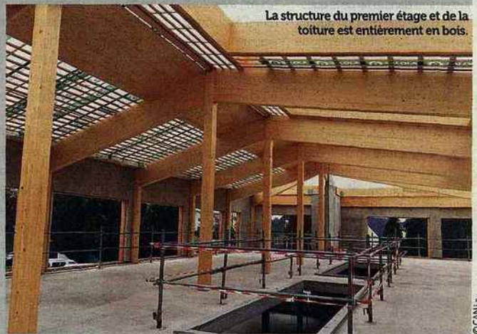
▼ Chaque module est contrôlé en atelier puis sur le chantier. Identifié, il trouve sa place au montage.
