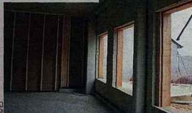
▲ Au sous-sol et dans le sas d'entrée, impossible d'intercaler des éléments préfabriqués entre le plancher et le voile de béton. Le béton de chanvre sera projeté dans des caissons (au fond, les parois du sas d'entrée, prêtes à recevoir le mélange).
